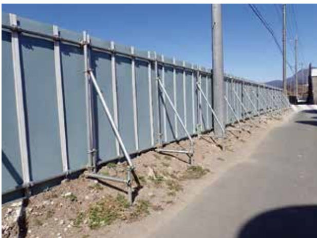
高い安全鋼板で「壁」を設置した事例
