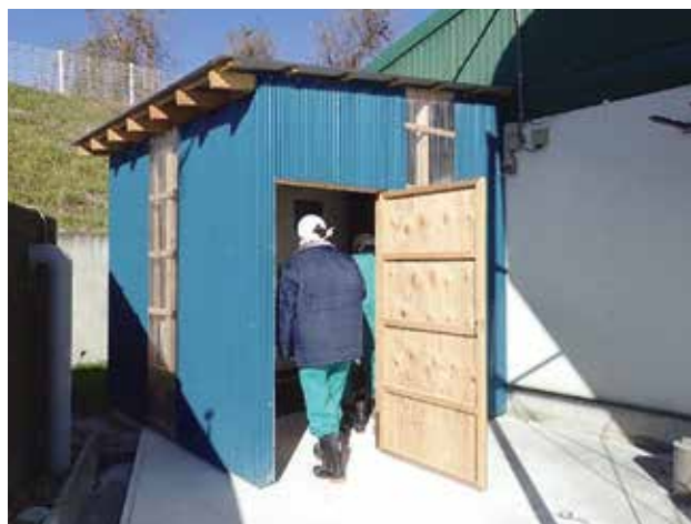
あとから追加設置した「前室」の事例(外観)
