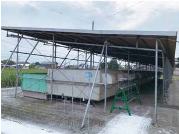
「トントンハウス」類の設置型豚舎を何台かまとめて屋根で覆った事例
