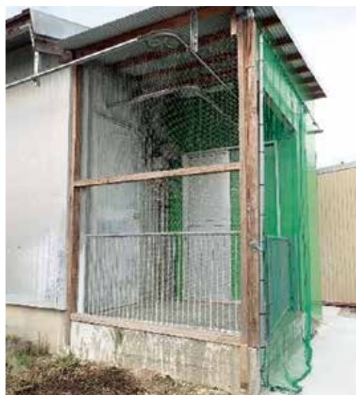
前室を設けて、人の出入り口と豚の出入り口を分けた事例
